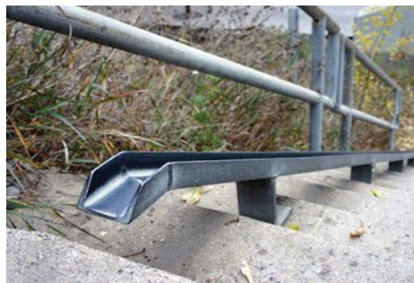
Figura 99 – Exemplos de dispositivos para bicicletas em escadarias Fonte: http://imaginefazerassim.blogspot.com.br/
