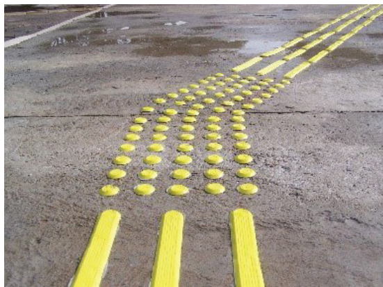
Figura 93 – Sinalização podotátil
